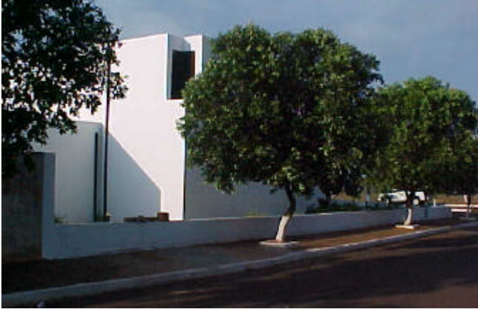
Vista lateral e detalhe de janela superior par iluminação zenital do ambiente de exposição de longa duração. Fonte Maury Rodrigues. 2003
