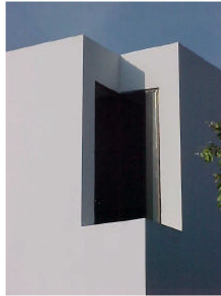
Vista lateral e detalhe de janela superior par iluminação zenital do ambiente de exposição de longa duração. Fonte Maury Rodrigues. 2003
